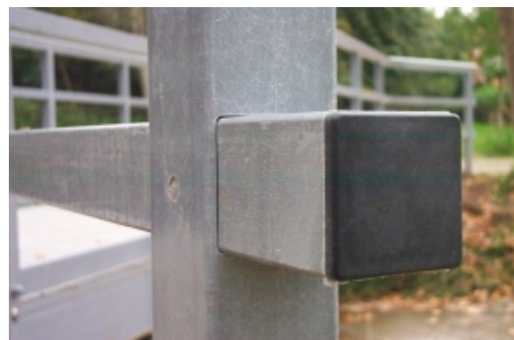
Verbindungsstelle von Pfosten und Knieleiste
