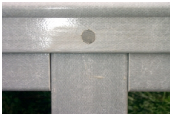
Verbindungsstelle von Pfosten und Handlauf
