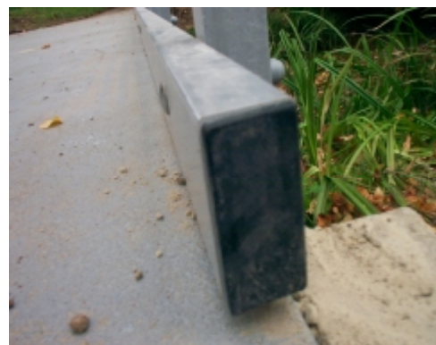
Besandeter Lauf- und Fahrweg, Fußleiste und Geländerpfosten
